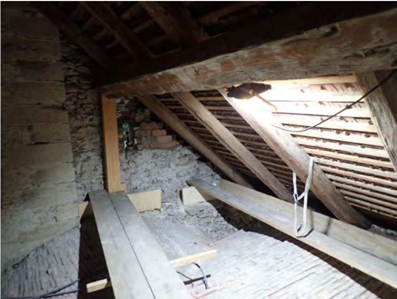
Abstützung Mittelpfette und Verstärkung Schwelle, Sakristei
