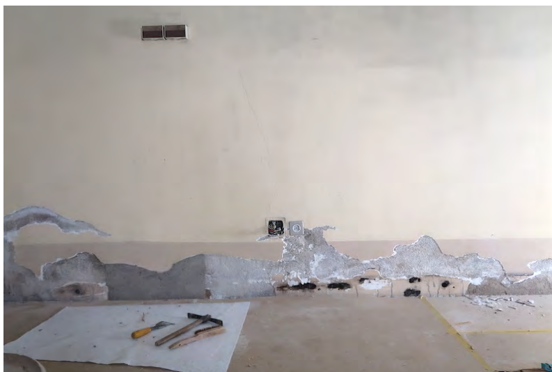
Sanierung des Sockelbereichs im Schiff | Der stark beeinträchtigte Verputz (Salze, Feuchtigkeit, mikrobiellen Befall) wurde entfernt. [[IMG_117 Massnahmen]
