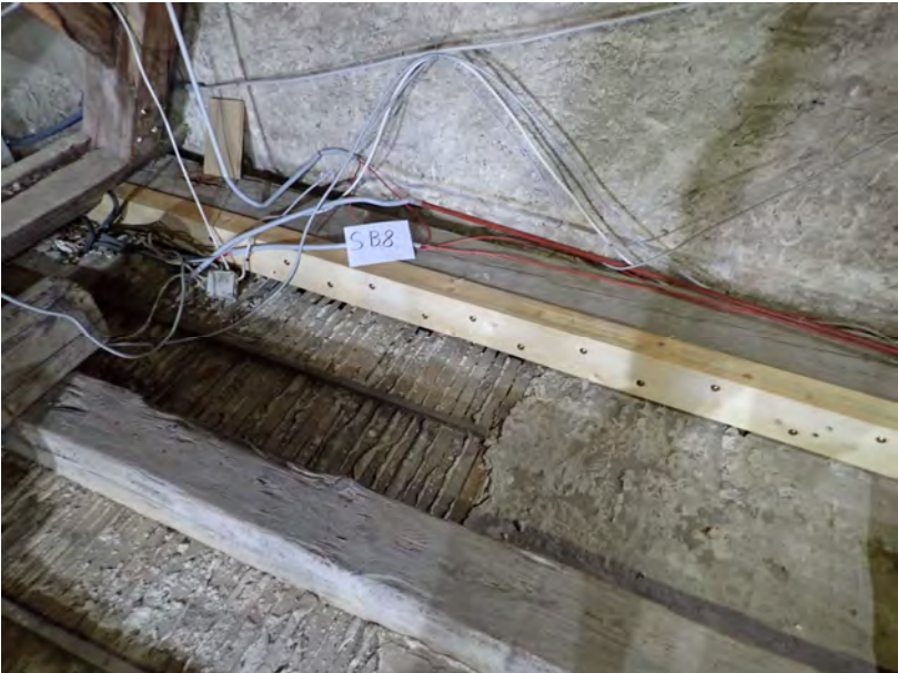
Binder 8, Süd, Balkenlage Lasche
