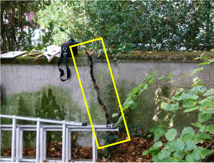
Durch Druckkontakt beschädigte Mauer
