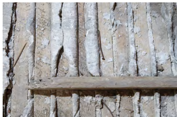
Detail Deckenkonstruktion mit Lattung und hervortretenden Putzwulsten [Abb. IMG_27 Massnahmen]
