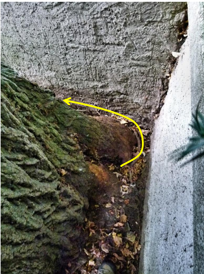
Durch Druckkontakt beschädigte Mauer
