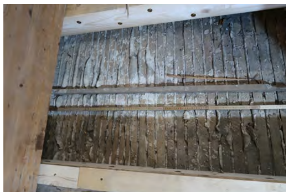
Dachboden mit Blick auf die Konstruktion der Deckenfläche des Chors [Abb. IMG_24 Massnahmen]
