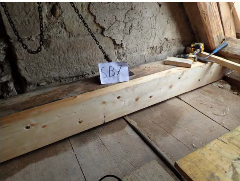
Balkenlage Binder 7, Süd
