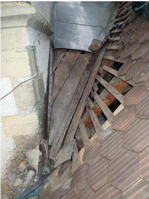
Kehlbereich bei Turm, vorher
