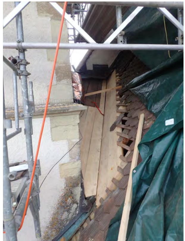
Kehlbereich bei Turm, nachher
