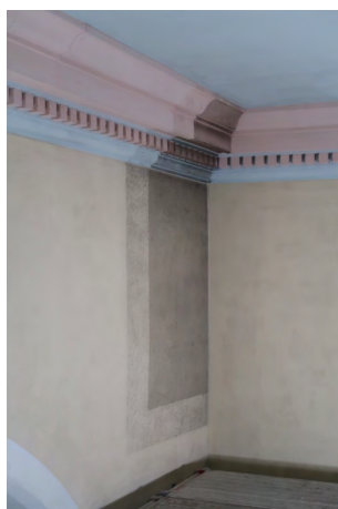
Referenzfläche der Reinigungsschritte im Chor (Trocken- und Feuchtreinigung) [IMG_116 Massnahmen]
