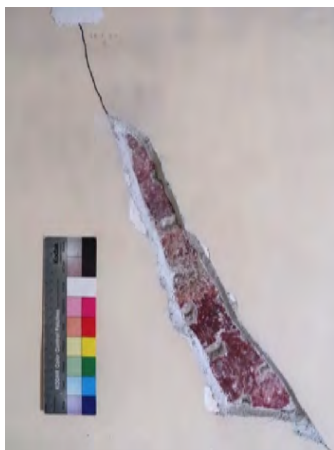
Barocker Kalkputz mit roter Malschicht, aufgeraut Im Bereich eines Risses mit Putzablösungen kam unterhalb der Putzschicht (19. Jh.) der frühere Verputz mitsamt Malschichtoberfläche zum Vorschein. [Chorwand (zum Schiff) IMG_19, Massnahmen]
