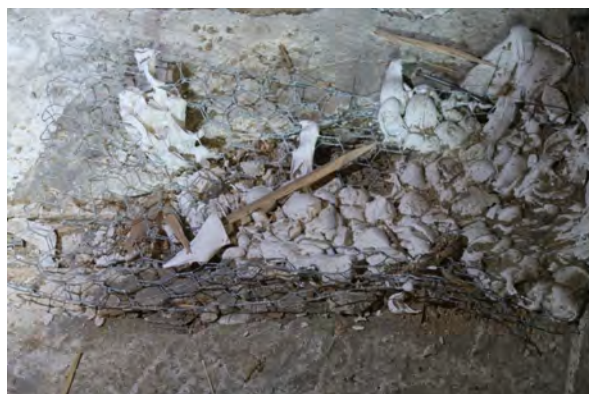
frühere Deckensicherung mit "Gipsbatzen" und Drahtgeflecht [Abb. IMG_30 Massnahmen]
