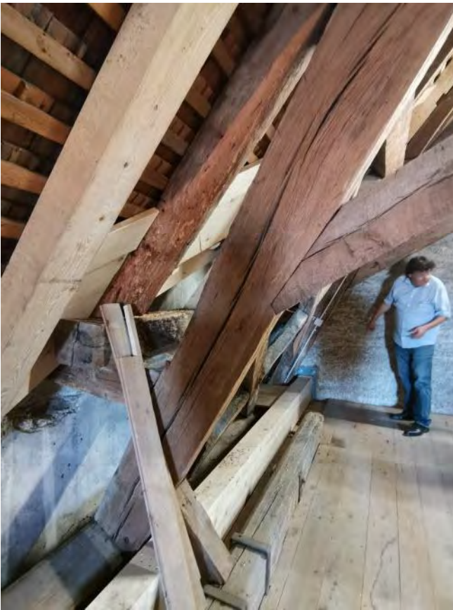
Binder 9, Süd, Bereich Turm
