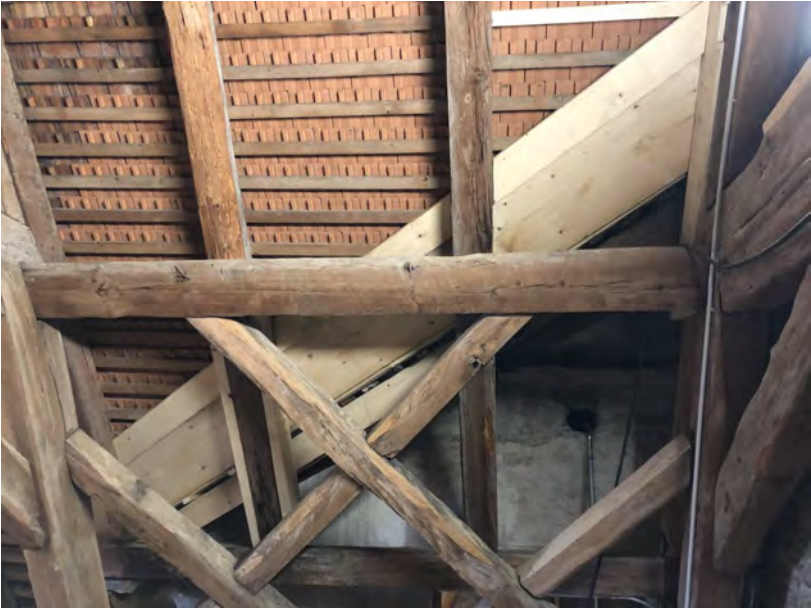
Kehlbereich Turm, innen, Süd
