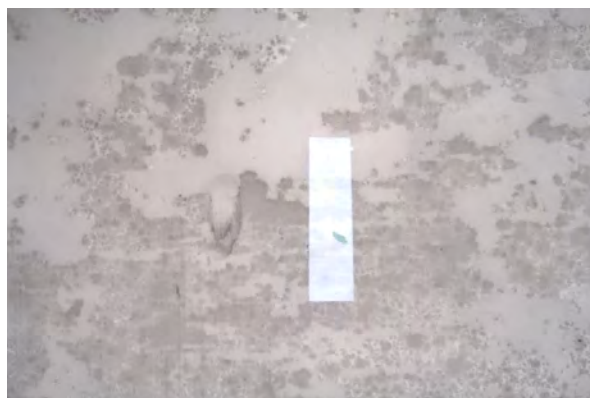
Detail Abb. links mit kl. Sondierung resp. Abnahme der Mattfarbe zur Überprüfung des Untergrunds [Abb. IMG_12 Massnahmen]
