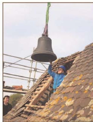
Mithilfe eines Krans wurde die Glocke zum geöffneten Dach des Kirchturms manövriert und dort abgeladen.
