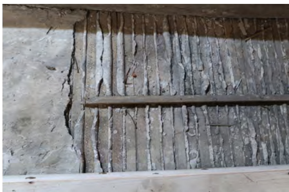
Abrupter Wechsel von flächiger Bockshaut zur Lattung mit Putzwülsten [Abb. IMG_26 Massnahmen]
