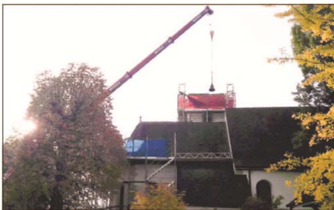
Mithilfe eines Krans wurde die Glocke zum geöffneten Dach des Kirchturms manövriert und dort abgeladen.
