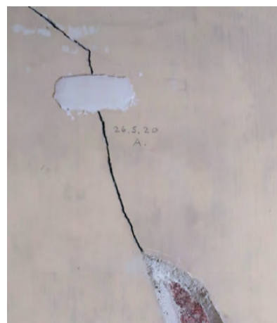
Rissmarke Chorwand zum Kirchenschiff [Ausschnitt. IMG_19 Massnahmen]
