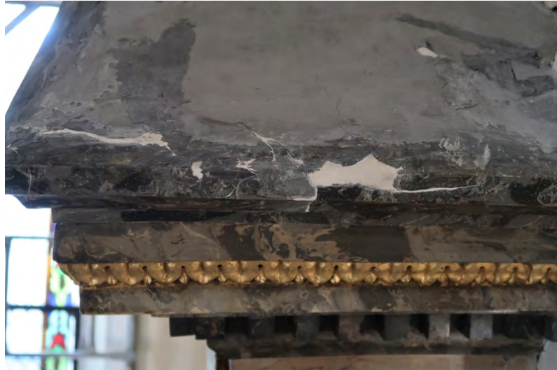
Detail Auskittung Altar [IMG_227 Massnahmen]
