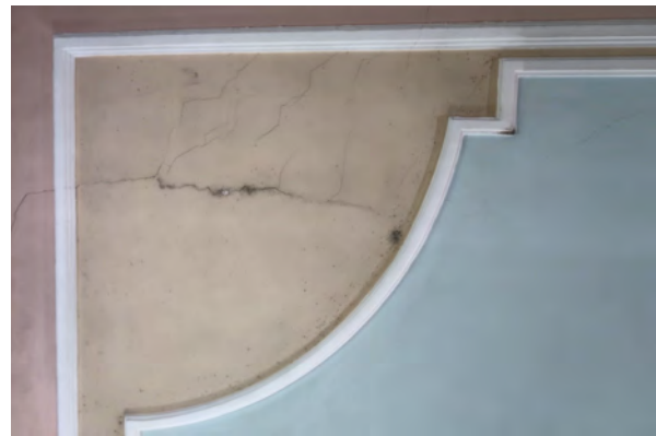
Deckenfläche | Das applizierte feinmaschige Gewebe im hellblauen Deckenspiegel hat sich bewährt, wohingegen die Risse in den gelben Flächen sowie der Hohlkehle ohne Geweben wieder gerissen sind. [Abb. IMG_09 Massnahmen]
