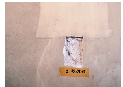
Sondierungsöffnung an der Wand im Kirchenschiff.
